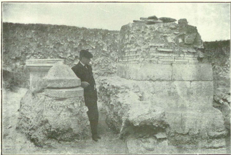
2. Stâlpul de N al turnului pătrat de NV. Le pilier N de la tour carrée du NO.
