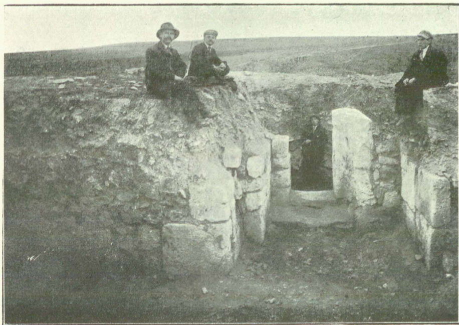
2. Poarta de pe laturea SE, văzută din interior (v. și planșa II nr. 1 și 2).
