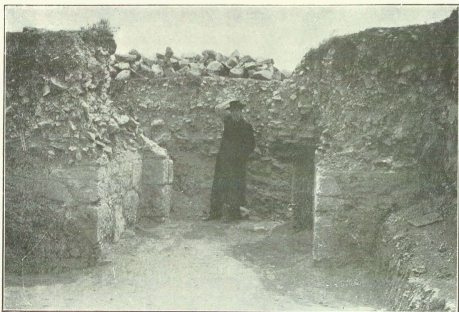
2. Intrarea turnului patrulater de NV, văzută din interior. L'entrée de la tour carrée du NO vue de l'intérieur.
