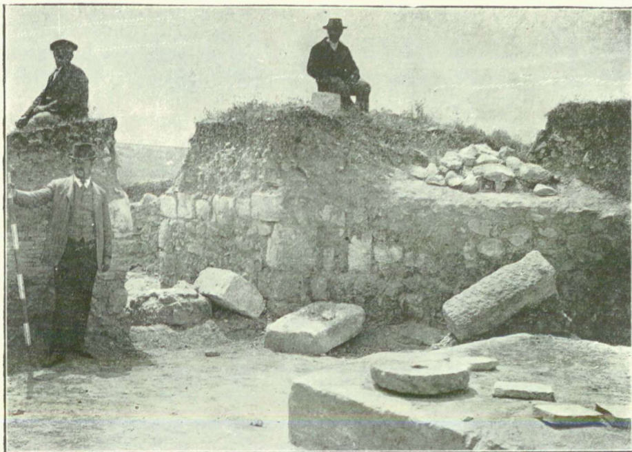
2. Stâlpul interior și intrarea turnului rotund de N. Le pilier intérieur et l'entrée de la tour ronde d'angle du N.
