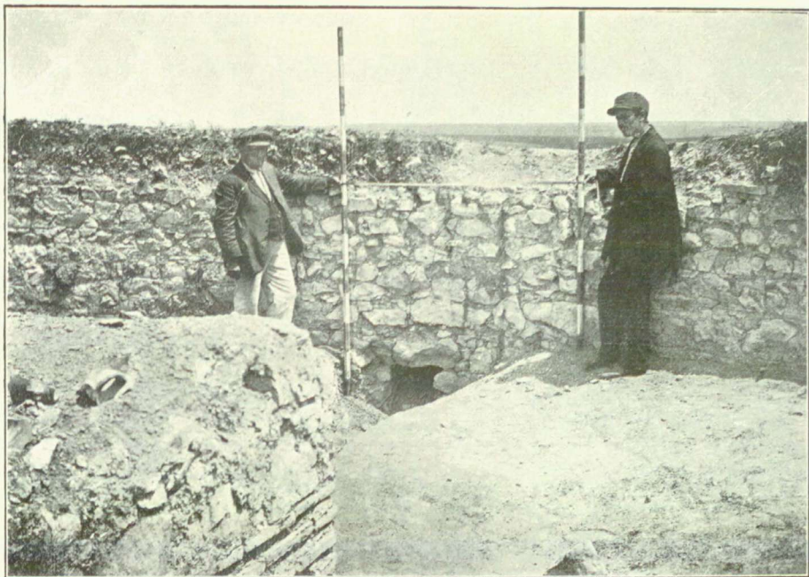
2. Vederea canalului din turnul rotund de Est. Vue de l'égout traversant le mur de la tour d'angle d'Est.
