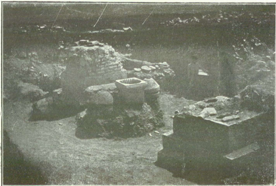
1. Vederea generală a interiorului turnului patrulater de NV. Vue générale de l'intérieur de la tour carrée du NO.
